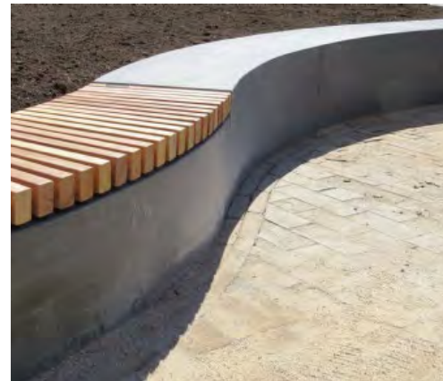
Betonnen zitranden met eventueel houten delen
