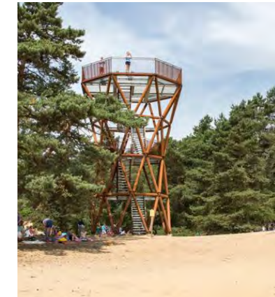
Houten uitkijktoren van zo'n 8 tot 10 meter hoog
