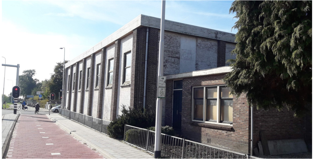
Figuur 21: Gebouw ter hoogte van de kruising van de N209/Dorpstraat dat mogelijk geschikt is als verblijfplaats voor de gierzwaluw of huismus.
