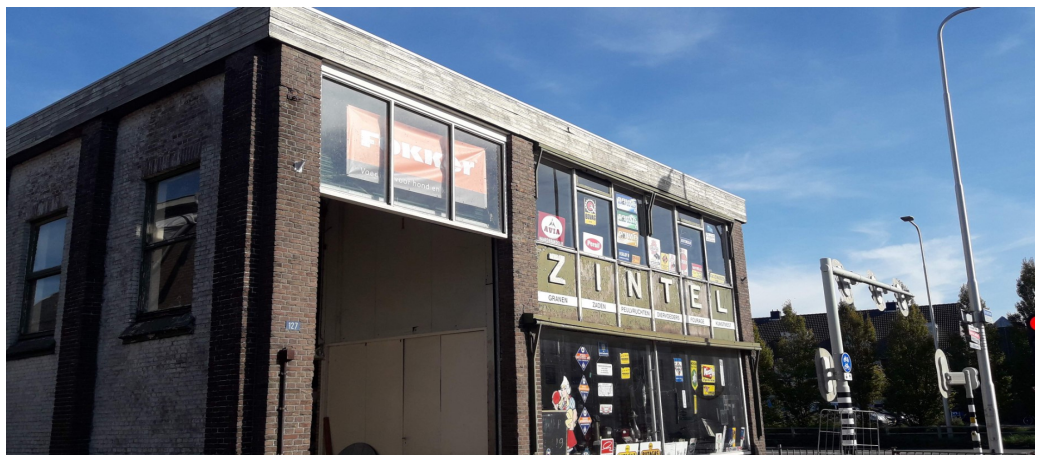
Figuur 31: Gebouw langs de kruising N209/dorpstraat waar geschikte verblijfplaatsen voor vleermuizen aanwezig zijn.
