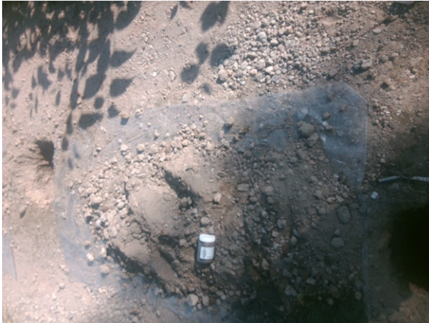
Fotonummer: 7 Omschrijving: Inspectiegat 205
