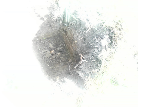
Fotonummer: 20 Omschrijving: Inspectiegat 302
