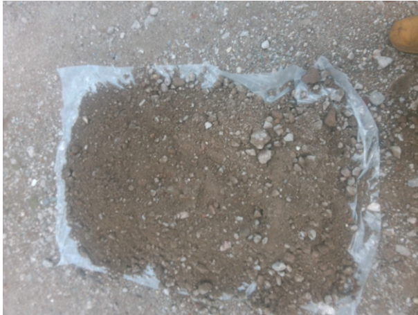
Fotonummer: 19 Omschrijving: Opgegraven materiaal inspectiegat 302
