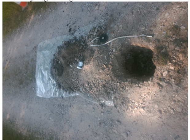
Fotonummer: 10 Omschrijving: Inspectiegat 206
