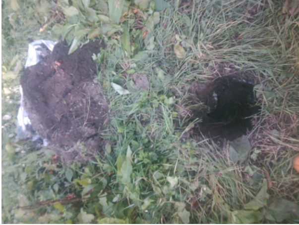
Fotonummer: 31 Omschrijving: Inspectiegat 309
