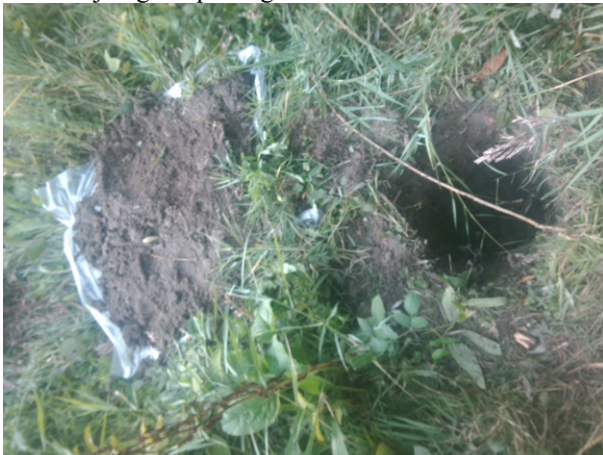
Fotonummer: 35 Omschrijving: Inspectiegat 311
