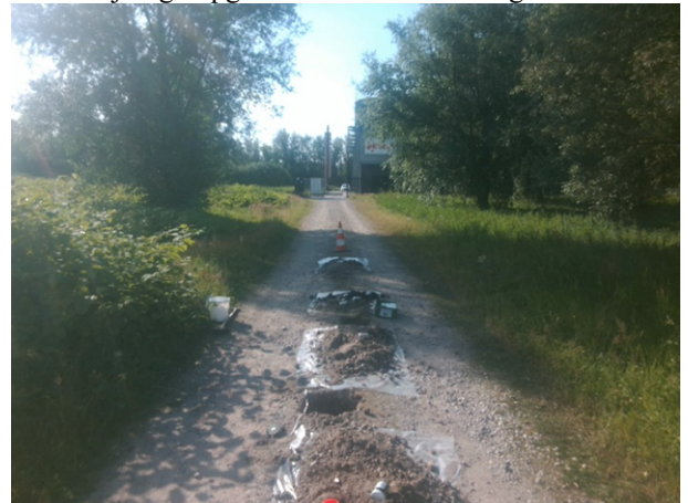
Fotonummer: 6 Omschrijving: Overzicht inspectiegaten 204 t/m 206
