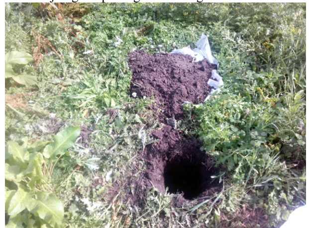
Fotonummer: 48 Omschrijving: Opgegraven materiaal inspectiegat 316
