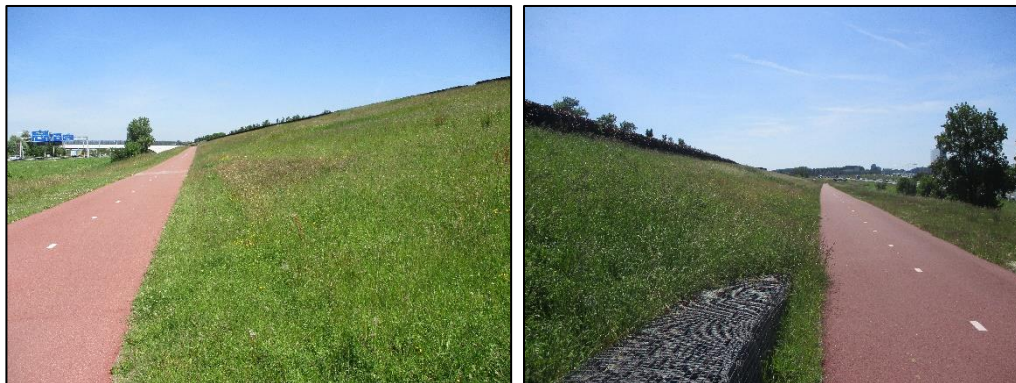
Impressies bloemrijk grasland op talud van geluidswal bij westelijk tracédeel (ten westen van Meyvlietpad).
