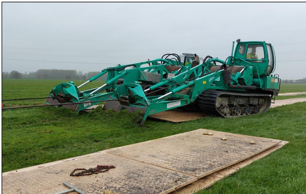
Figuur 3-2: Twee rupsvoertuigen met lier. Door het oprollen van de staalkabels trekt deze de ploeg naar zich toe.
