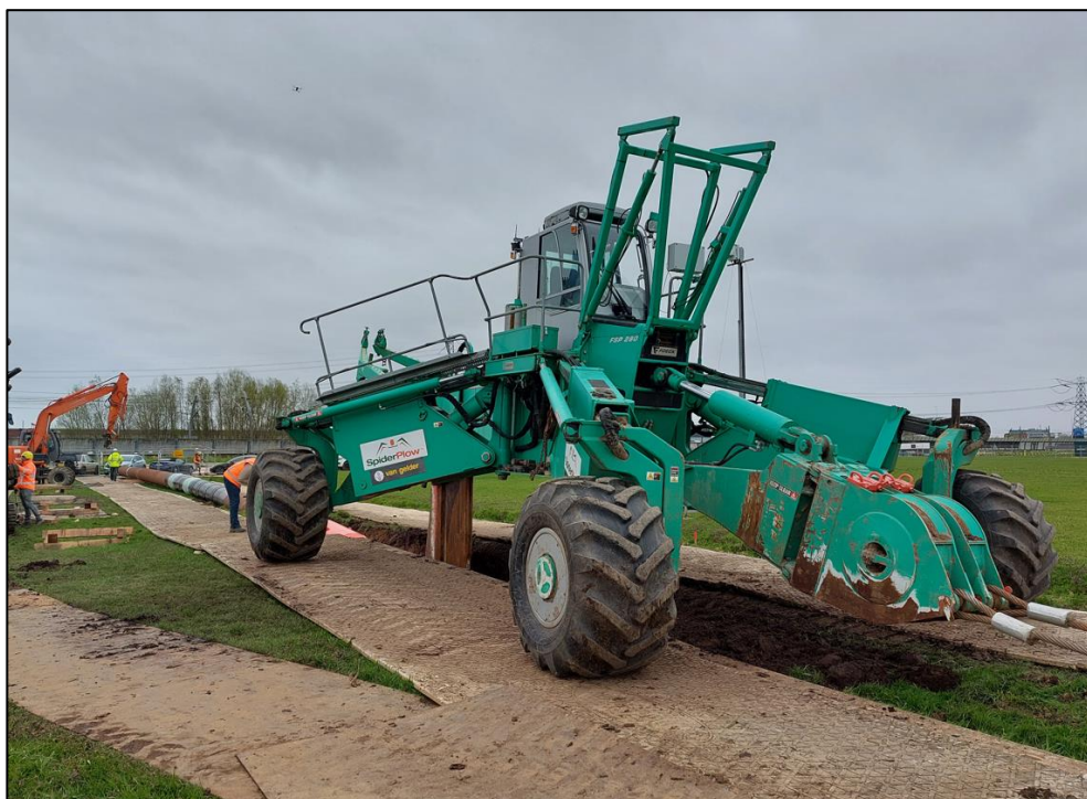
Figuur 3-1: De ploeg Inploegen grote diameter Leidingen.
