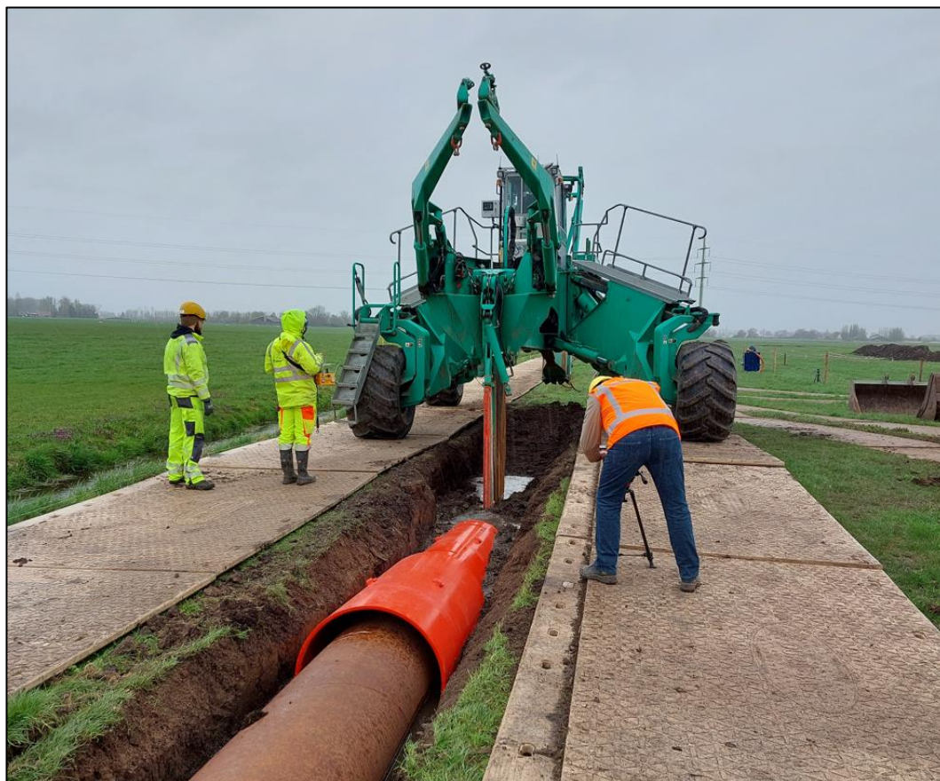
Figuur 3-5: Detail opname torpedo met 28" leiding.
