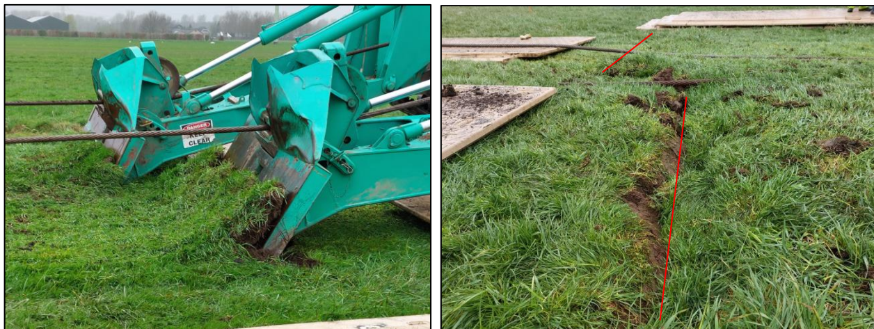
Figuur 5-3: Liervoertuigen bij intrekken 28 inch leiding
