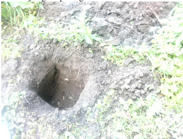
Fotonummer: 39 Omschrijving: Inspectiegat 313
