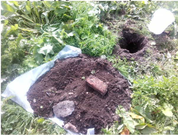
Fotonummer: 21 Omschrijving: Inspectiegat 303
