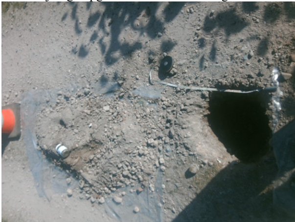
Fotonummer: 5 Omschrijving: Inspectiegat 204
