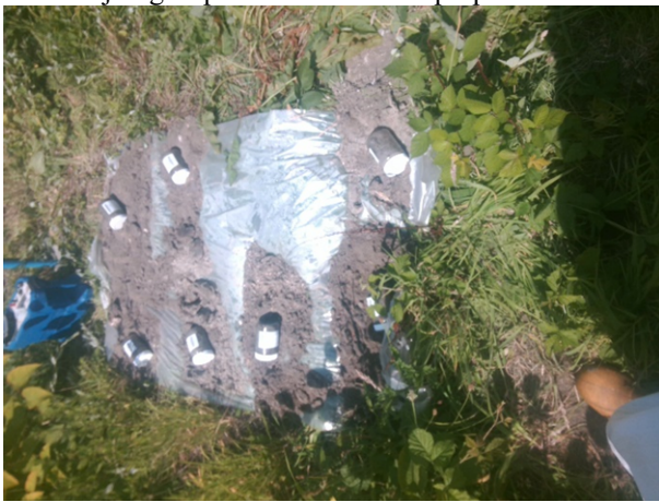
Fotonummer: 3 Omschrijving: Opgeboord materiaal boring 202-A
