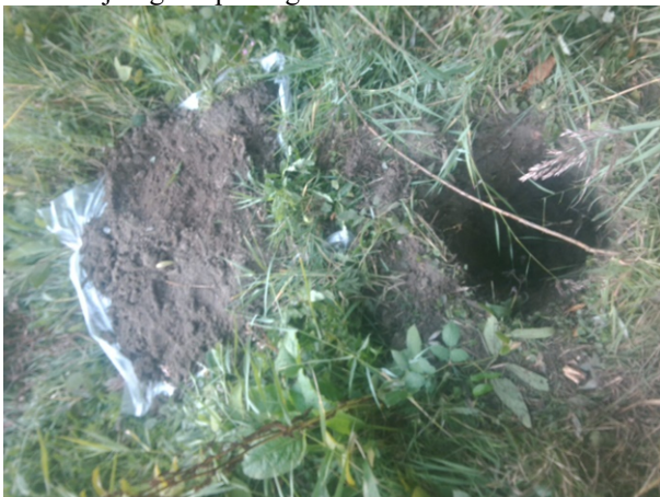
Fotonummer: 35 Omschrijving: Inspectiegat 311
