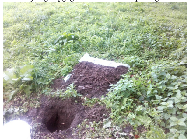
Fotonummer: 40 Omschrijving: Opgegraven materiaal inspectiegat 313
