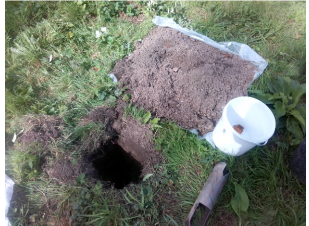
Fotonummer: 44 Omschrijving: Inspectiegat 315
