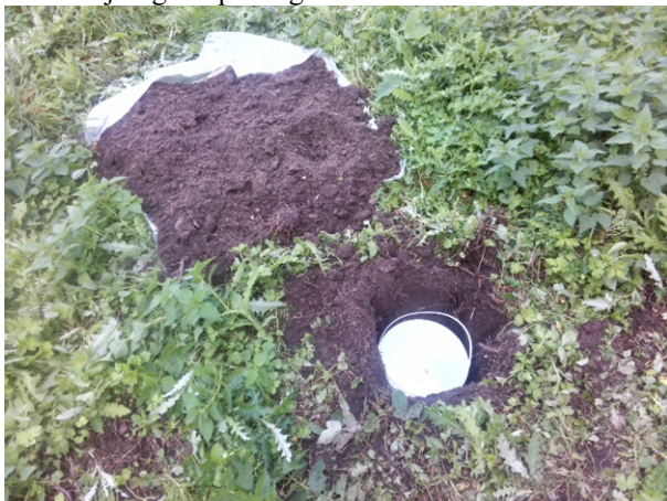
Fotonummer: 41 Omschrijving: Inspectiegat 314
