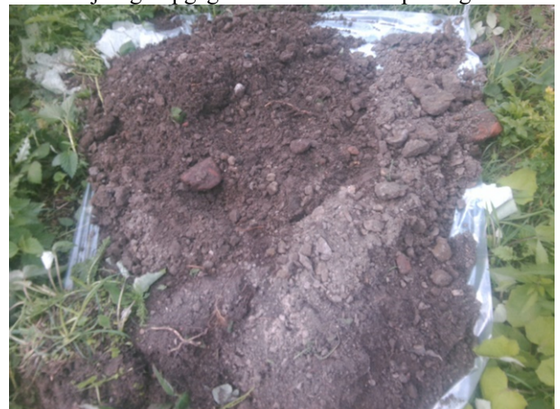
Fotonummer: 30 Omschrijving: Opgegraven materiaal inspectiegat 308
