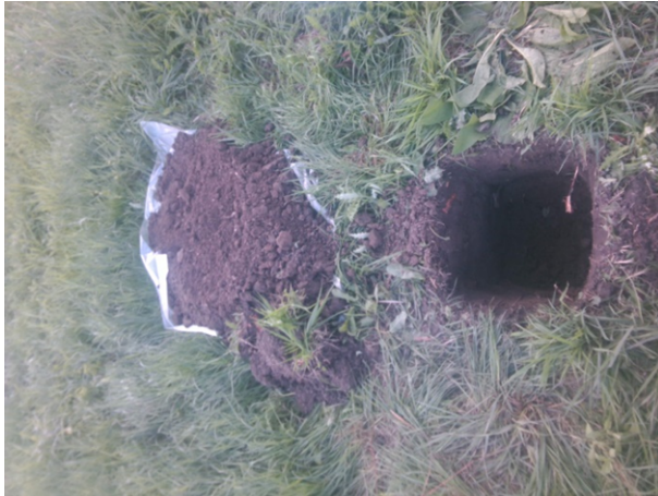
Fotonummer: 25 Omschrijving: Inspectiegat 306
