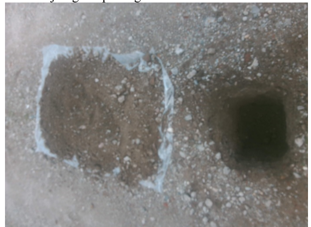
Fotonummer: 18 Omschrijving: Inspectiegat 302
