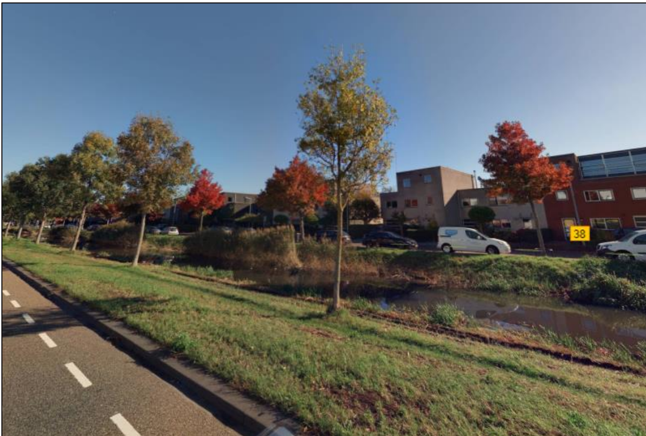
Figuur 4. Foto van het nieuwe deelgebied waar een open ontgraving gaat plaatsvinden, ter hoogte van Oude Middenweg 38 Den Haag. Bron: Cyclomedia.
