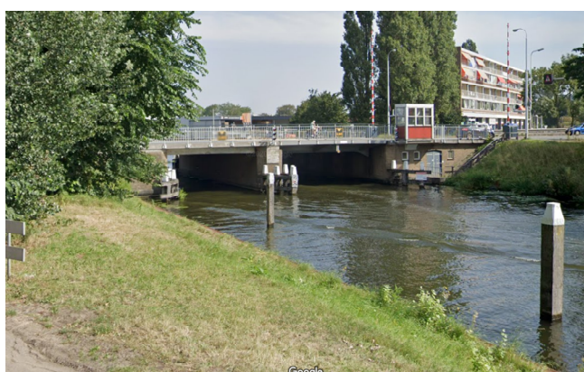
Figuur 1.4 Impressie van de vliegroutes (van boven naar onder de Vrouwenvaart, Rijn-Schiekanaal en Trekvliet met de kunstwerken die onderdeel zijn van de werkzaamheden aan de N206-Europaweg.
