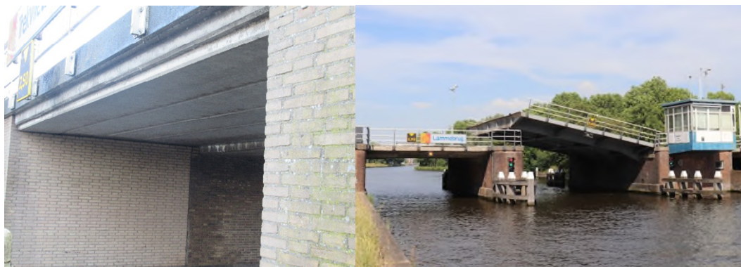
Figuur 4.2. Links: Trekvljetbrug met losse betonplaten. Rechts: Lammebrug met mogelijk geschikte locaties voor vleermuizen (foto M. van Beelen juni 2021).
