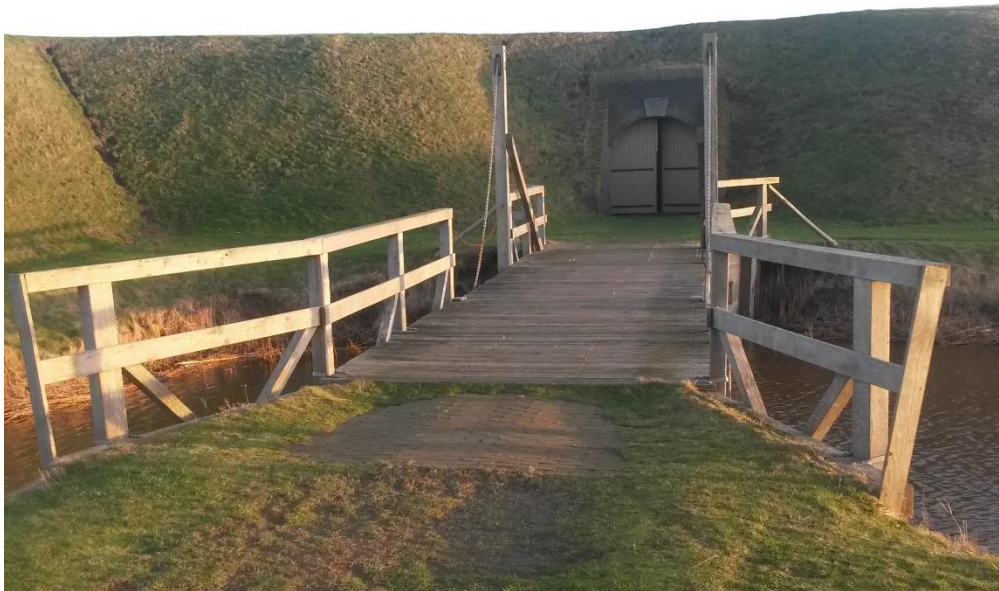
Figuur 21. Ingang van het Staatse fort De Schans op Texel, met in de omlijsting van de poort natuurstenen elementen.
